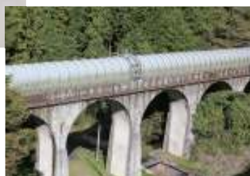
太田川から発電所への水路橋
