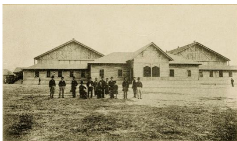
臨時に建てられたものだがとても立派（広島市公文書館所蔵「絵はがきに見る戦前の広島街と市民の暮らし」より）
