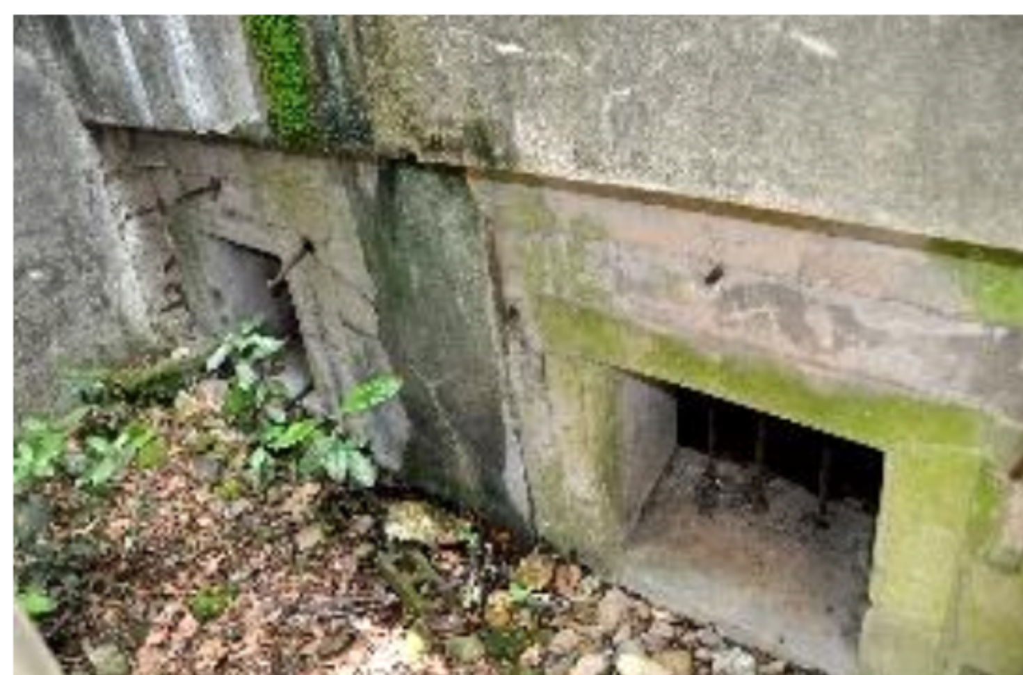
指揮連絡室の窓
