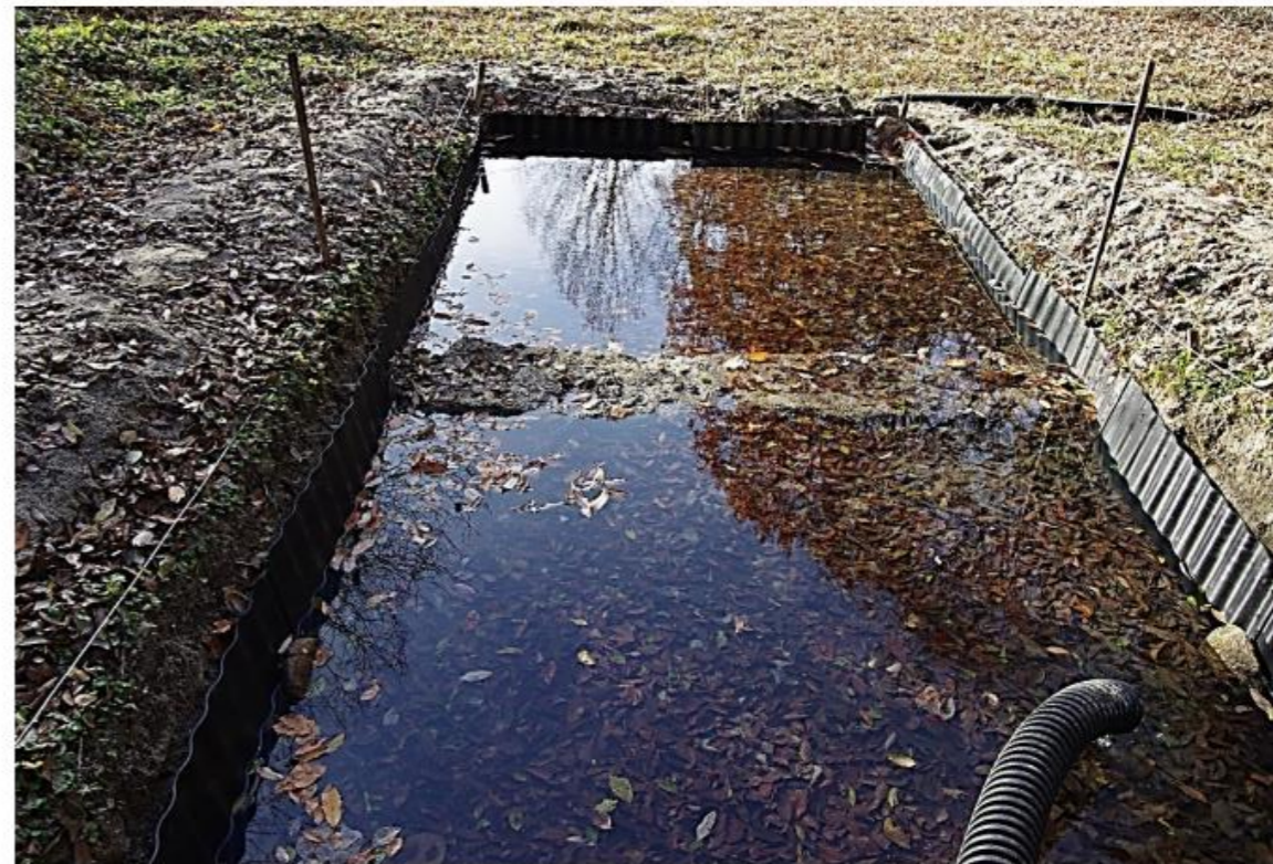
↑（完成した池 3m×6m、深さ50cm）（2020年12月）
