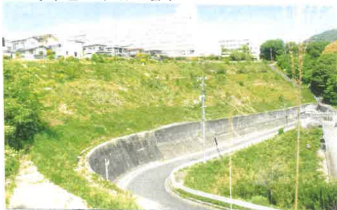
②法面の全体像。南北に4本の排水溝で区切られ、東西は五か所の縦溝で区分されています。法面の傾斜角度は30度で三角形のコンクリート製型枠で構築されている。
