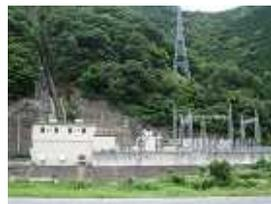
日本海へ注ぐ水を水路工事でのこの地へ運び発電している。完成したのは昭和五十年。発電容量は三十八万キロワット。一般家庭の夏場の利用に換算して一万二千六百戸分という。
