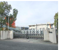
28) 広島市福島ポンプ場
