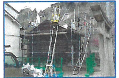
弁天さん倉庫の瓦をふき替え中
