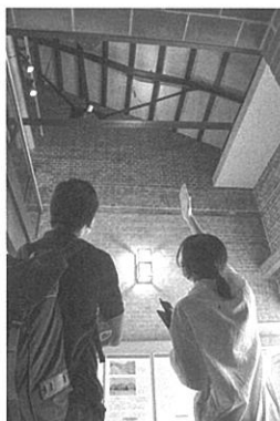
原爆の爆風で曲がった屋根の鉄骨の説明 (昨年の様子)
