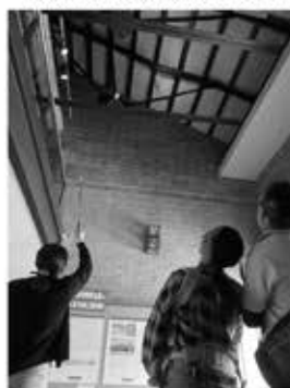
原爆の爆風で曲がった鉄骨の解説
