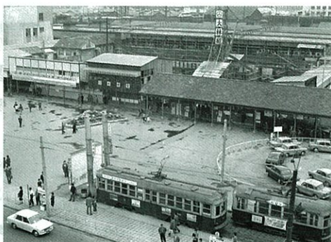
▲「路面電車と工事中の広島駅」昭和39年(1964) 広島市広報課 撮影・広島市公文書館 提供
