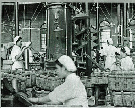
製缶工程 ライニングマシン 昭和15~17年頃(1940~42)(個人蔵)
