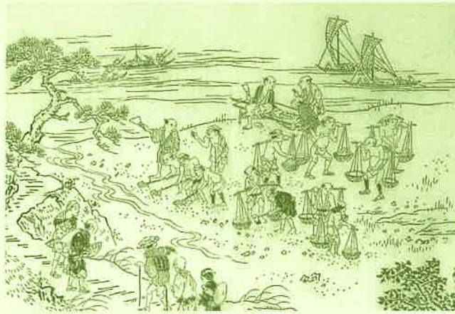
八木用水の工事のようす【芸備孝義伝拾遺】より 広島市立中央図書館蔵
