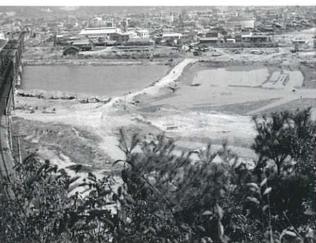
工事の様子 昭和39年(1964)
