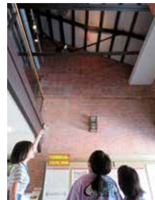
▲曲がった鉄骨の説明の様子
