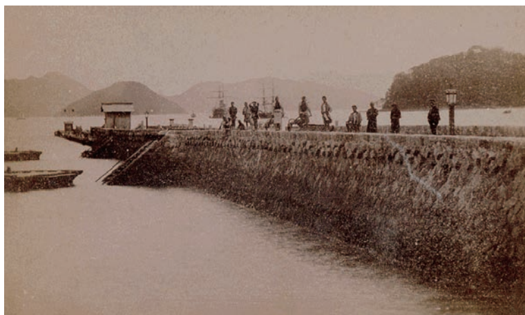
港時の宇品港栈橋(後の軍用栈橋)
