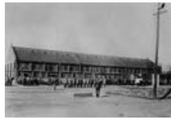
【写真③】 写真 広島陸軍被服支廠 13番庫
