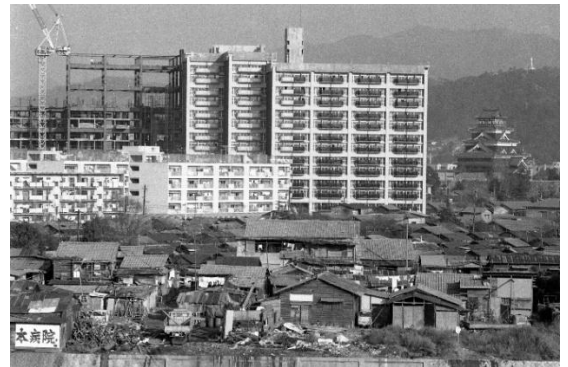
1970年 建設中の基町高層アパート (広島市広報課撮影・広島市公文書館提供)
