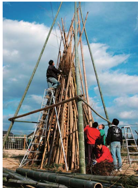
力仕事はオヤジの番。すごいスピードで組み上がっていきます
