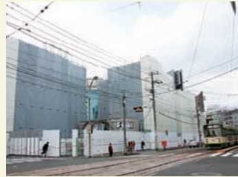
▲猿猴橋町電停(下り)付近ビル解体中 (純喫茶パールのあった付近 撮影日2013.2.7)
