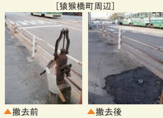
▲撤去前 ▲撤去後
