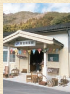
▲旧安芸飯室駅の駅舎
