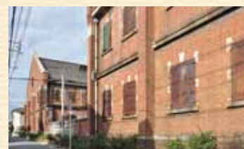
▲ 旧陸軍被服支廠倉庫の外観
