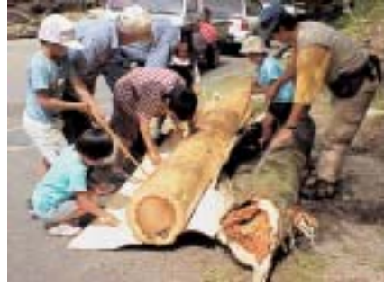
木の皮むき。ログハウスの材料に
