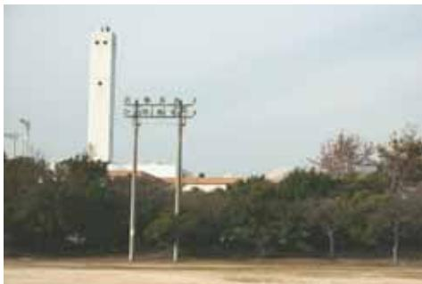
1983年(昭和58)に完成した出島処理場は、くみ取り便所からのし尿<sup>による</sup>を処理するし尿<sup>による</sup>処理施設と浄化槽<sup>おでい</sup>汚泥処理施設の2つの役割を持っています。両施設とも1日に300,000リットルを処理する能力があります。
