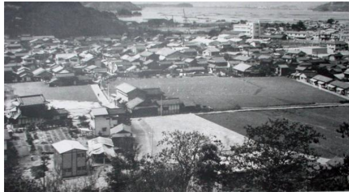
㊦昭和42年。中央の角地（かどち）は矢野町役場（現在・安芸区役所矢野出張所）の新地（さらち）
