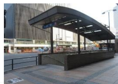
地下道 6 番出入口
